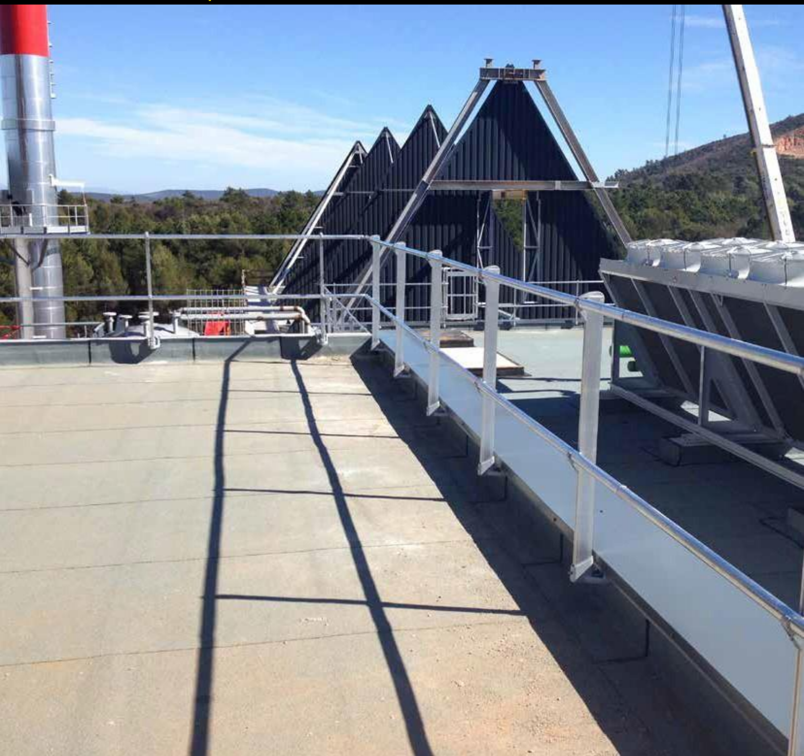
Různé možnosti svislé polohy podle typu upevnění a podle výšky ochranné zídky.
